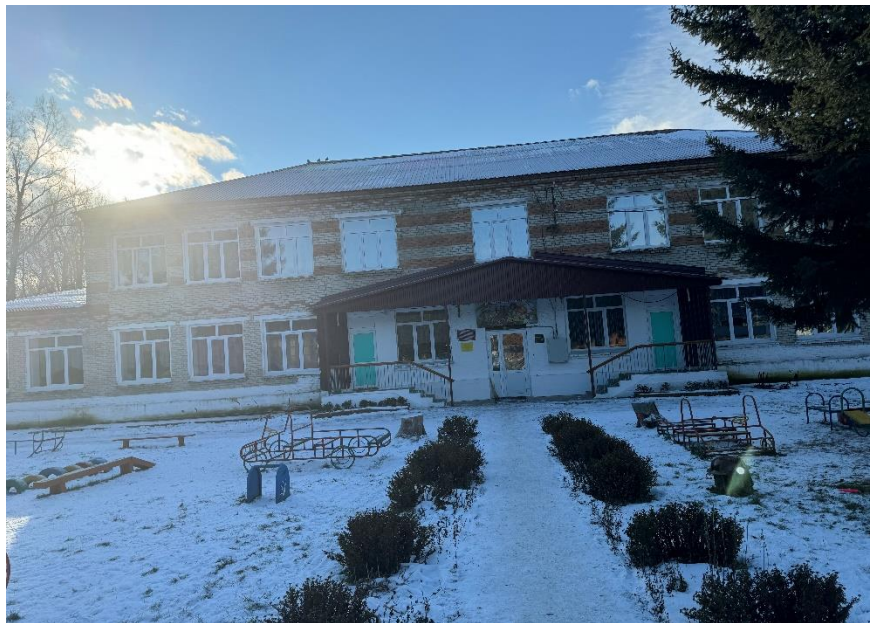
Общий вид обследуемого здания
